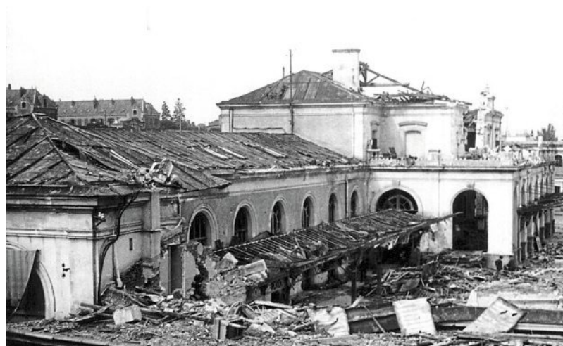
Le bâtiment principal de la gare de Rennes a beaucoup souffert du bombardement.
